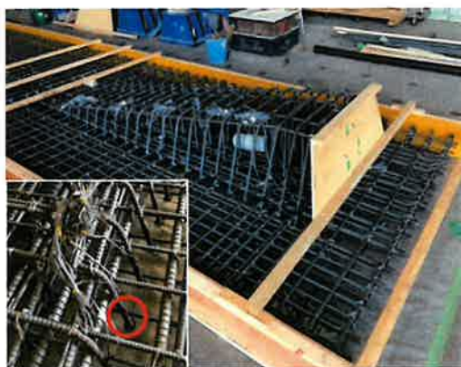
Trunc-head 配筋状況
