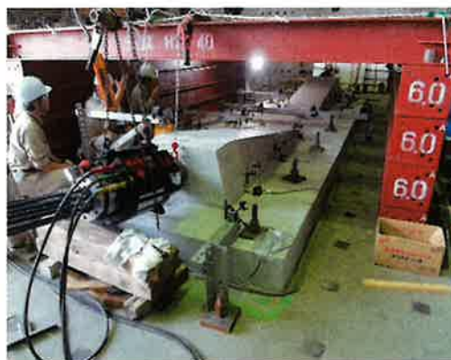
PC 鋼材を用いた載荷試験
